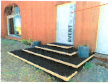
Treppe zu Scheune
