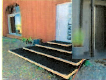
Treppe zu Scheune
