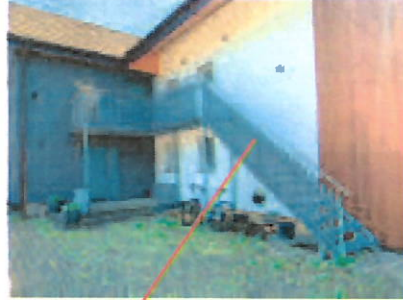
Zugangstreppe zu Einliegerwohnung
