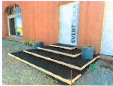
Treppe zu Scheune
